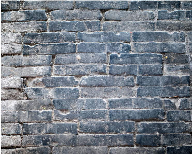
fig.17 Blue Brick ( 古建家园 , 2019)
